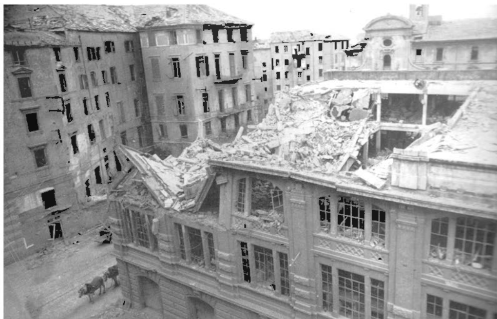
Il palazzo del Mercato Coperto semidistrutto dal bombardamento del 30 ottobre 1943. (Archivio fotografico Bruno Chionetti).
