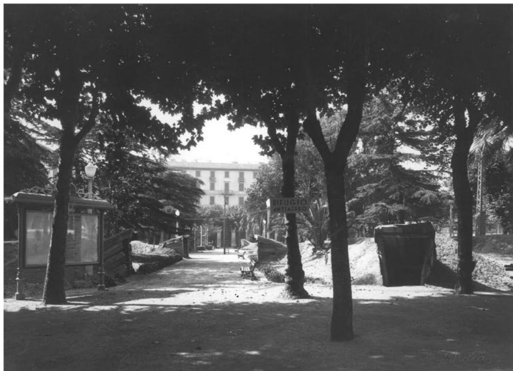
Rifugio antisceghe in piazza del Re sul lato di Via Caboto.
