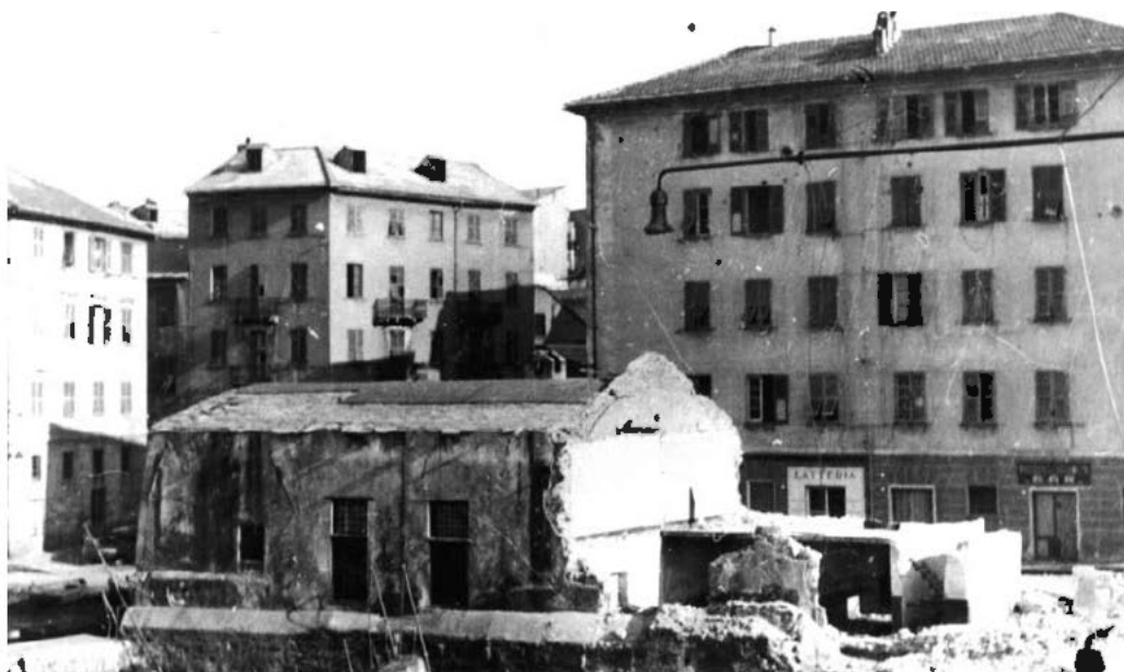
La "Casa dei colombi", all'inizio di via Baglietto, in una fotografia scattata all'indomani del bombardamento del 30 ottobre 1943. (Archivio fotografico Bruno Chionetti).
