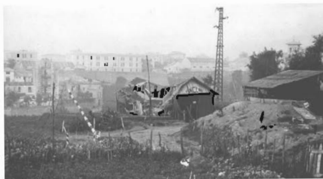
Via Turati: orti e baraccamenti parzialmente danneeggiati dai bombardamenti.
