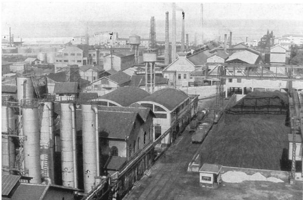
Veduta panoramica della Formicoke di Vado Ligure.
