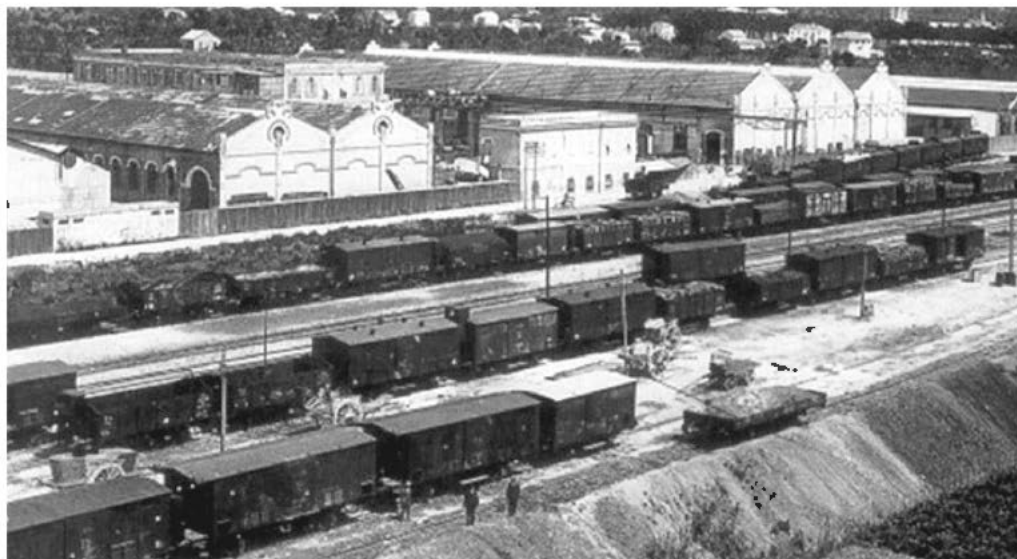
Veduta panoramica della Brown Boveri di Vado Ligure.
